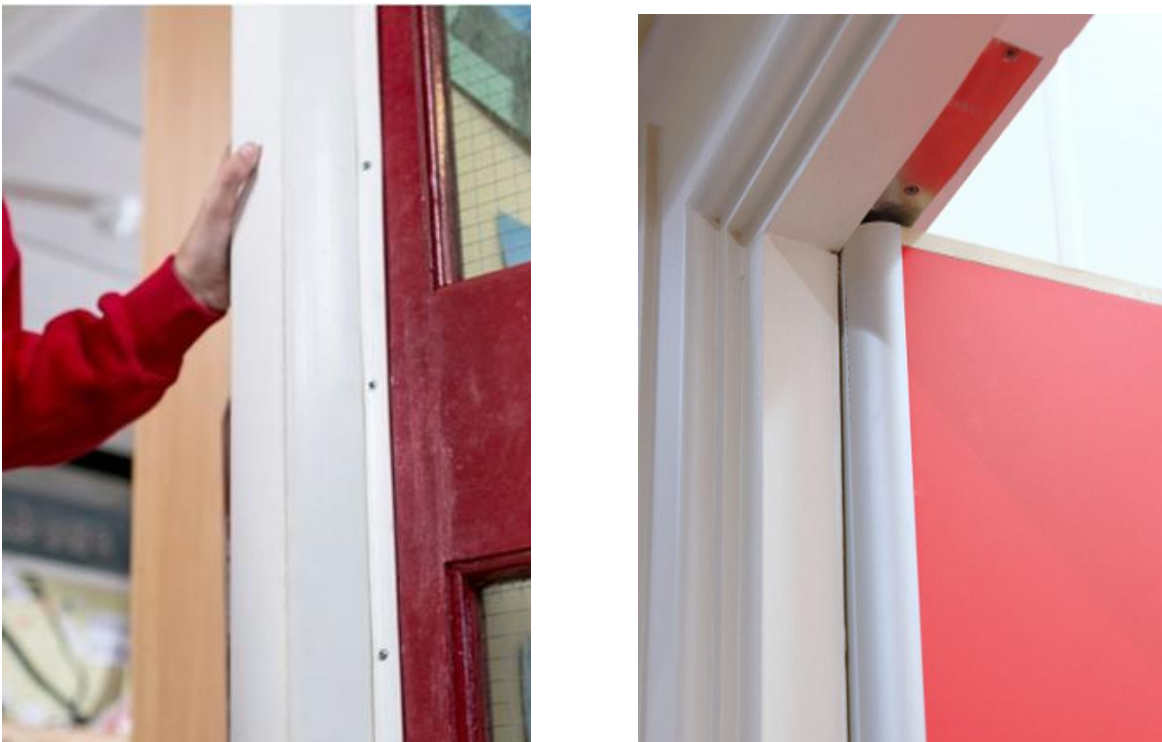
Cael gwared â phwyntiau pinsio/gwasgu drwy osod gardiau colfachau neu osod drysau newydd â gardiau colfachau integredig.
